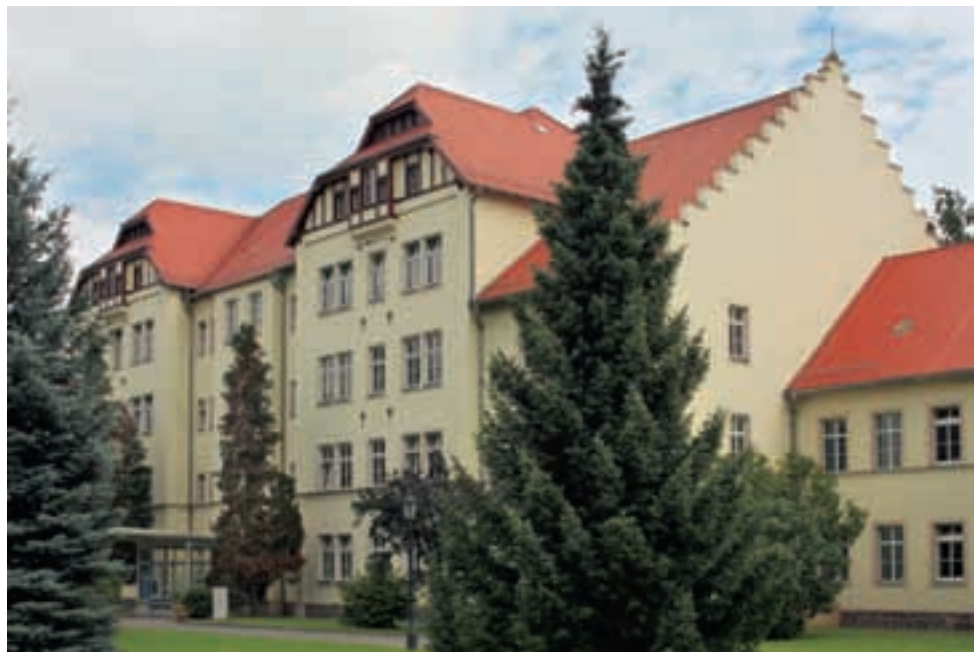
Das Bethanien-Krankenhaus im sächsischen Westewitz heizt mit der Heiz-Energie des Blockheizkraftwerks.
