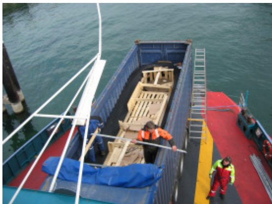
Bild 1: Am laufenden Meter: In einem Stück wurde das Nexans-LWL-Seekabel gefertigt und geliefert. Es wiegt insgesamt etwa 30 Tonnen und musste in einem gigantischen Container, in mehreren Lagen aufgewickelt, transportiert werden. Der Verzicht auf Spleißstellen reduziert das Risiko von Schäden und sorgt für eine optimale Datenübertragung.
