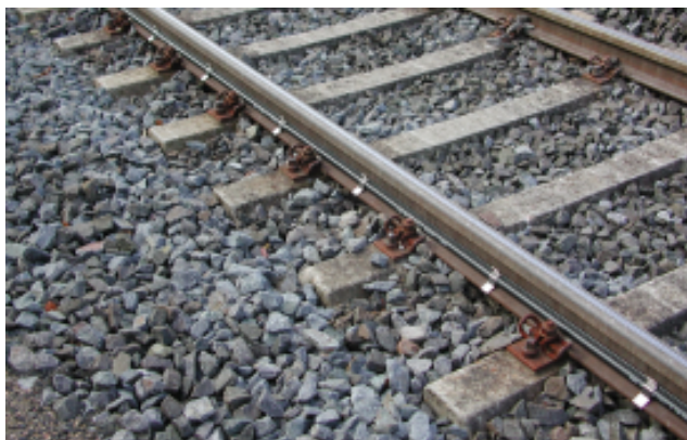
Das Nexans-DuoTrack-Kabel wird direkt an der Schiene montiert und stellt damit eine interessante Alternative zur zeit- und kostenintensiven Trogverlegung dar. Muffen, Klammern und eine speziell abgestimmte Verletechnik runden das System ab.
