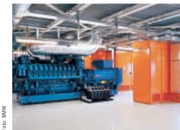
Die 20V-4000-Aggregate von MTU stehen in der Energiezentrale bereit.
