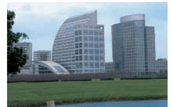
Sicherheit im Hochhaus: Gensets versorgen bei Netzausfall zum Beispiel Notbeleuchtung und Rauchmelder.
