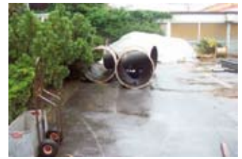
■ Die Luft strömte durch ein Stahlblech-Rohrleitungsnetz mit bis zu 1 m Durchmesser, das die Halle durchzog. Bild: Nießing
