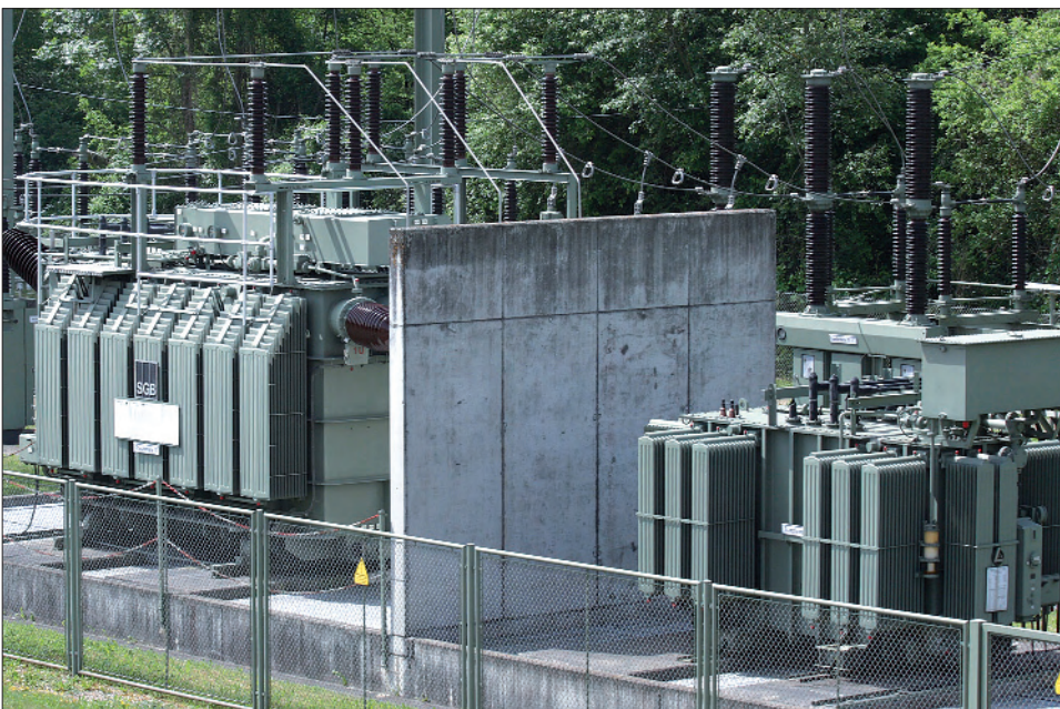
Das Umspannwerk Langweid bei Augsburg ist Einspeisepunkt für das benachbarte BEW-Wasserkraftwerk Langweid und transformiert die Spannung von 10 über 20 auf 110 kV. Es ist zugleich ein kleiner Knotenpunkt im Netz der LEW; links das Umspannwerk +
