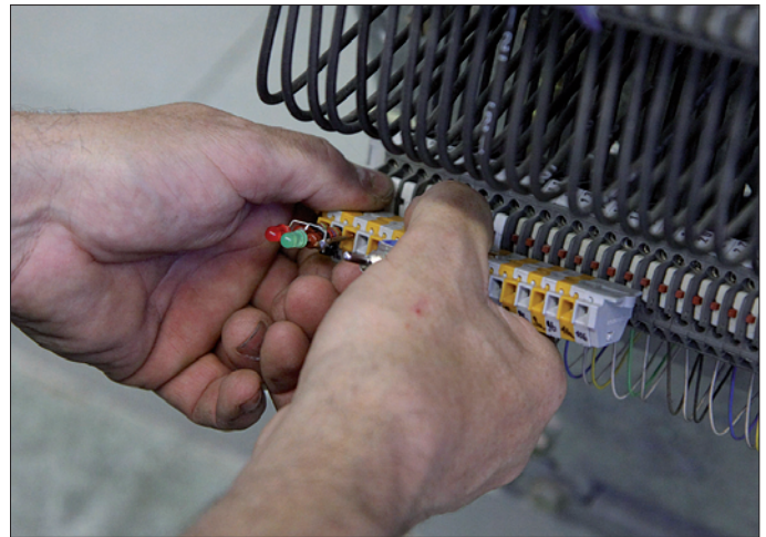
Statt Schalthandlungen auszulösen, lassen die Testbefehle der Netzleitstelle im Umspannwerk nur Dioden am Testgerät glimmen
