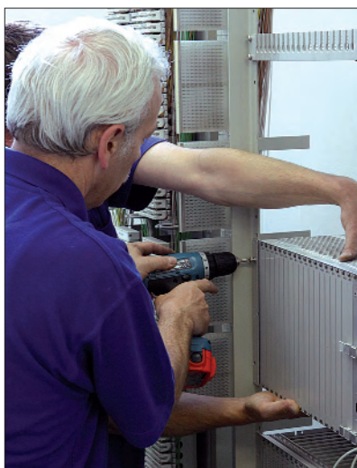
Danach werden alle Leitungen sowie alte Kabelsätze entfernt und das Fernwirkgerät ausgebaut
