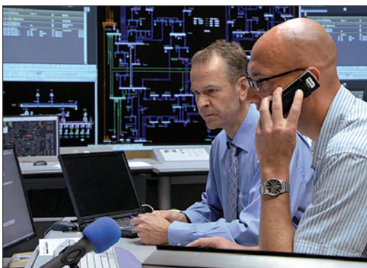
W. Meier und Ch. Moser prüfen, ob die simulierten Rückmeldungen aus dem Umspannwerk in der Netzleitstelle sichtbar sind
