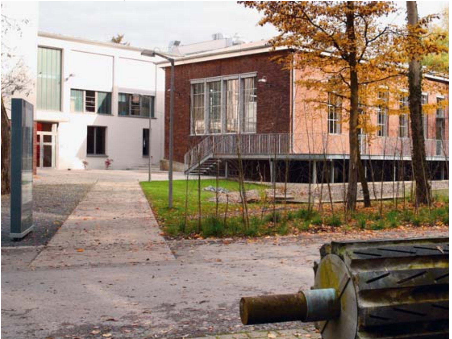
Kantinegebäude der umgebauten Brügger Mühle: Auf dem hundert Jahre alten Industriegelände entstand ein Büropark mit modernem Komfort.
